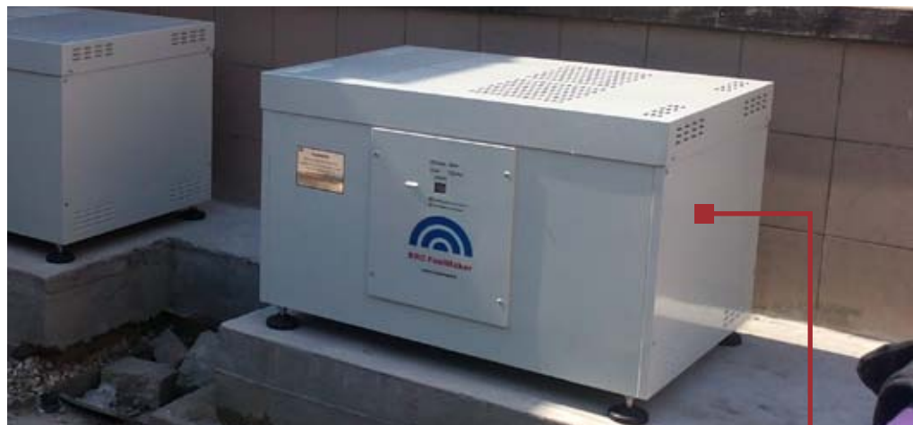
Big Q – FMQ 10 – kompresor o dużej wydajności 14 m 3 /1 h przy napięciu sieciowym 230 V 50 Hz
